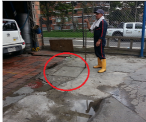
Foto No. 2. Vista general del pozo pz-13-0005.
