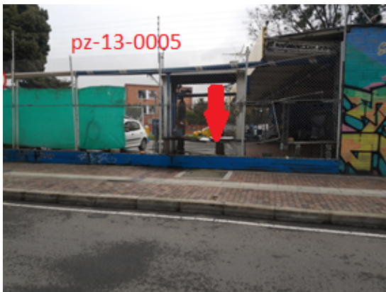
Fotografía 3 Modificación de la vía y ubicación del pozo dentro del predio según coordenadas ya establecidas.
