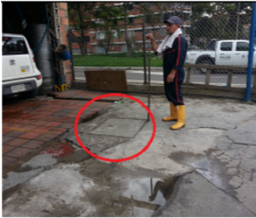
Fotografía 1. Localización aparente del pozo pz-13-0005, según oficio 2013EE176411 del 23/12/2013. La cual si fue verificada durante la visita realizada el 15/11/2017.
