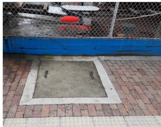
Fotografía 4 Caja de inspección de desagüe, ubicada fuera del predio por donde interviene la modificación vial realizada por el IDU.
